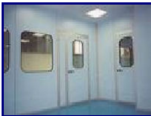
Figura 8. Se muestra con los acabados que deben de tener las ventanas
